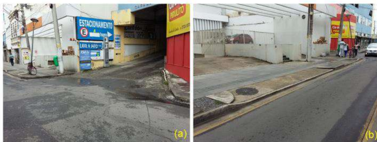
Figura 102 - Interrupção de calçada (a) e continuidade de calçada (b) na Zona Centro Histórico de Campos dos Goytacazes – RJ
